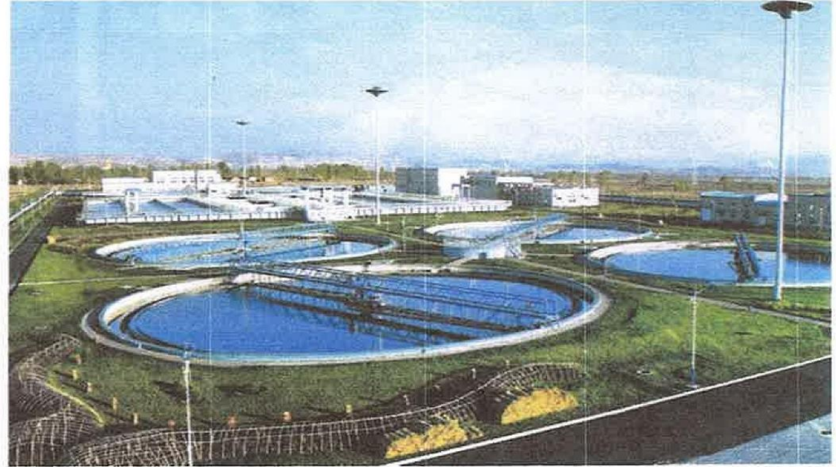
โรงบำบัดน้ำเสีย
